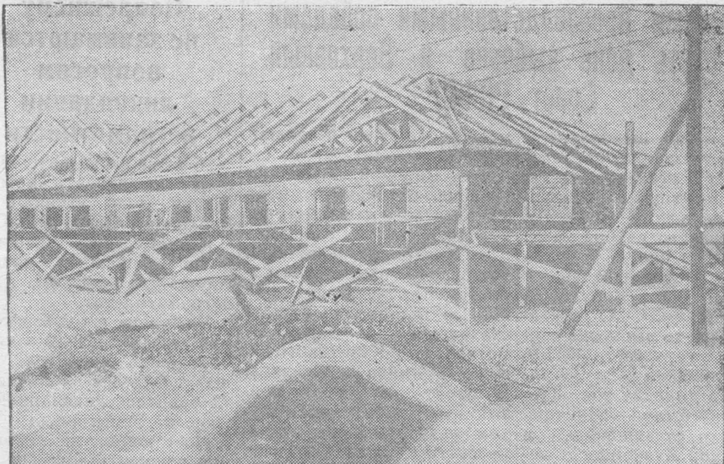
Строительство города Киселевска. На снимке: один из строящихся каменных домов для горняков шахты № 3. Фото Дмитриева.
