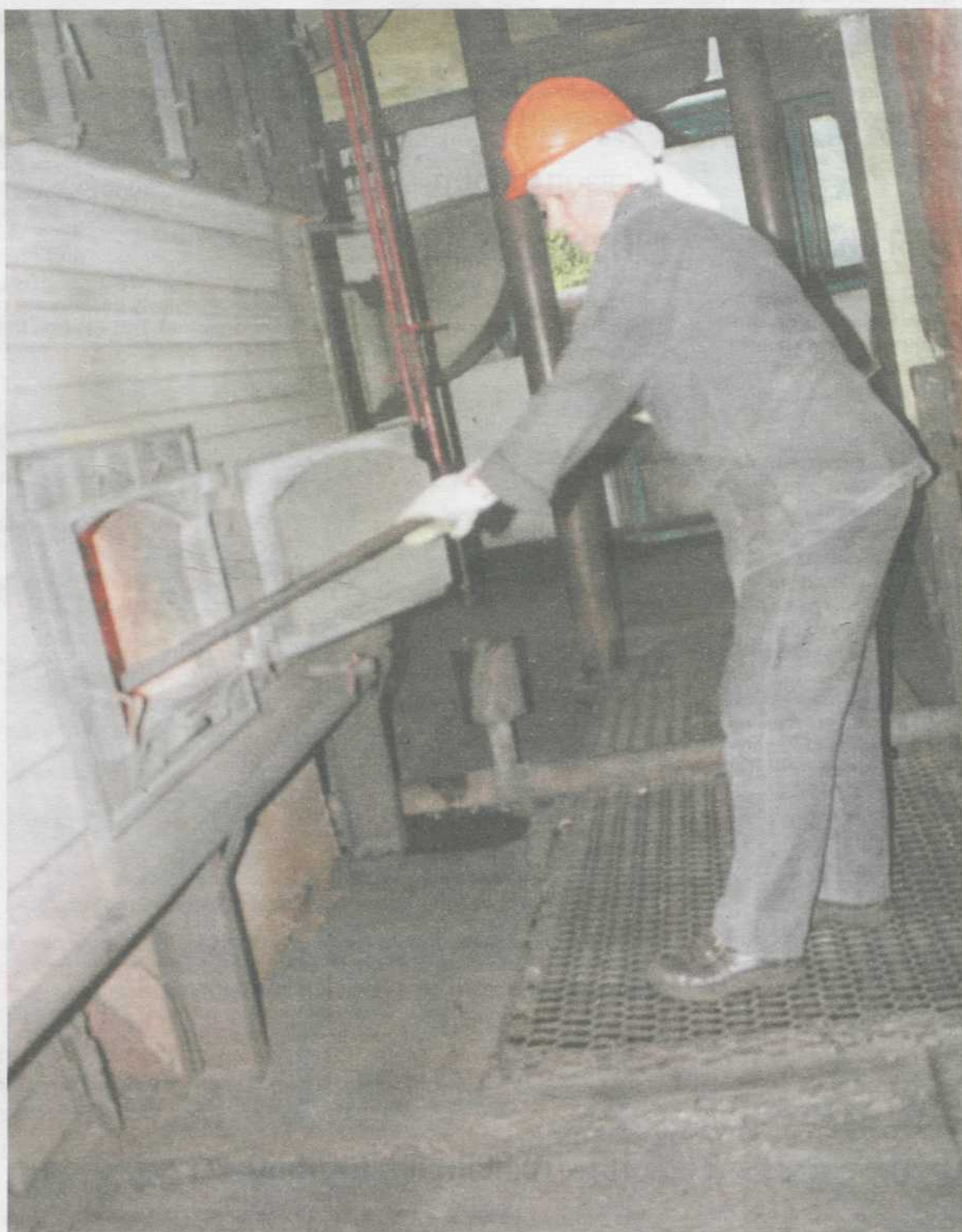
В котельной по ул. Садовая пос. Малиновка. Фото Д. Мальковой
