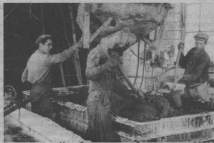
Цех сборного железобетона
