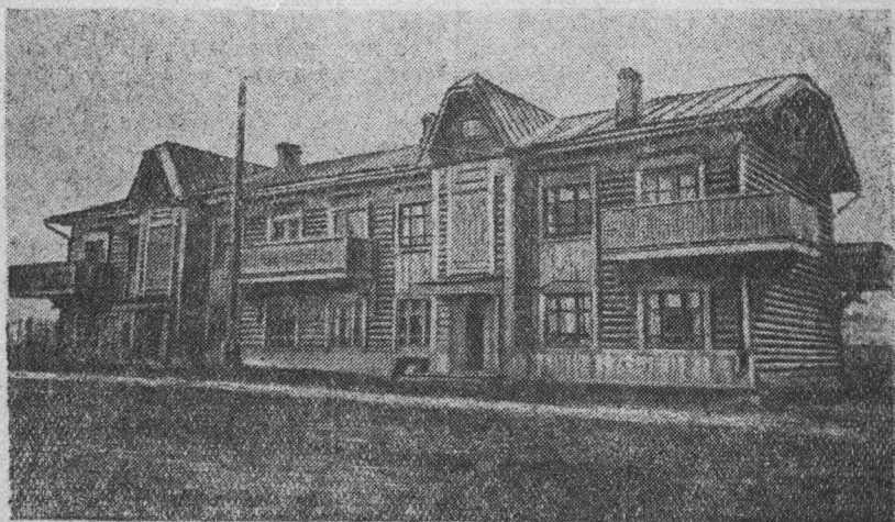
С каждым годом расширяется жилищный фонд Гурьевского металлургического завода. На снимке: вновь выстроенный 16-квартирный жилой дом.
