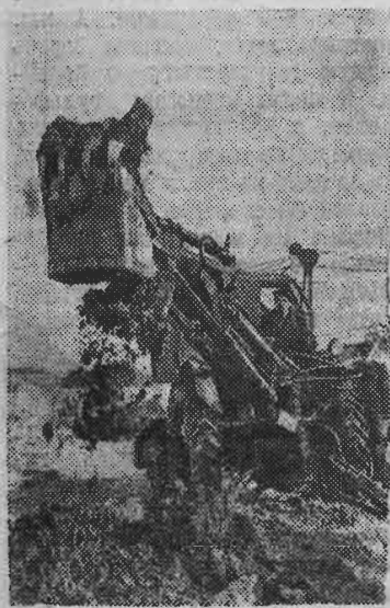
На снимке: испытание экскаватора.
