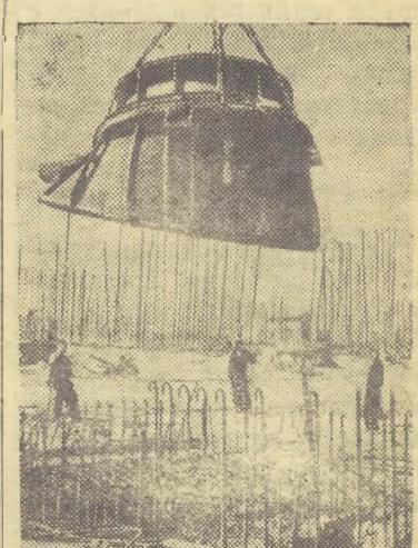
**ВОЛГОДОНСТРОЙ.** Монтажники водоносной станции Карловского водохранилища, борясь за досрочное завершение работ, решили вести монтаж мощных насосных агрегатов одновременно с бетонными работами.
