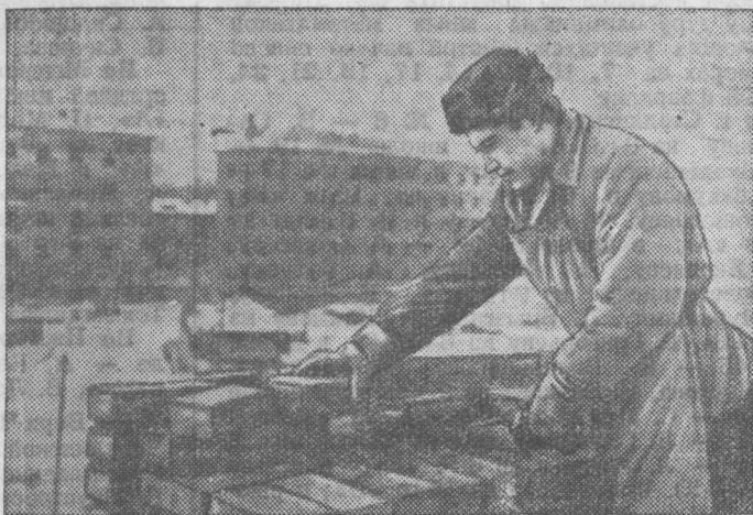
В Сталинске днем и ночью ведутся работы на строительстве новой средней школы по улице Кирова. Здесь трудится молодежная комплексная бригада треста «Сталинскпромстрой», которой руководит Иван Еремеев.
