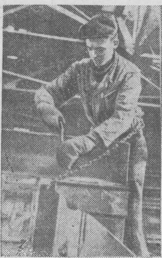
Работая на строительстве цехов ширпотреба при КМК, монтажник Николай Ткаченко из месяца в месяц выполняет норму при отличном качестве работы.
