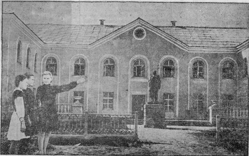
Мы будем учиться в новой школе! На снимке: новал школа в Заводском районе г. Кемерово.
