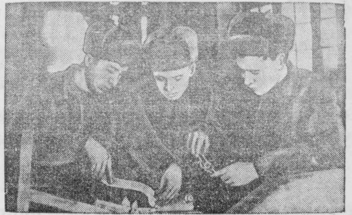
На шахту «Центральная» (Кемерово) поступил новый мощный пневматический двигатель. Его монтаж поручен лучшим молодым слесарям тт. Лаврушину, Самушеву и Вахтину.
