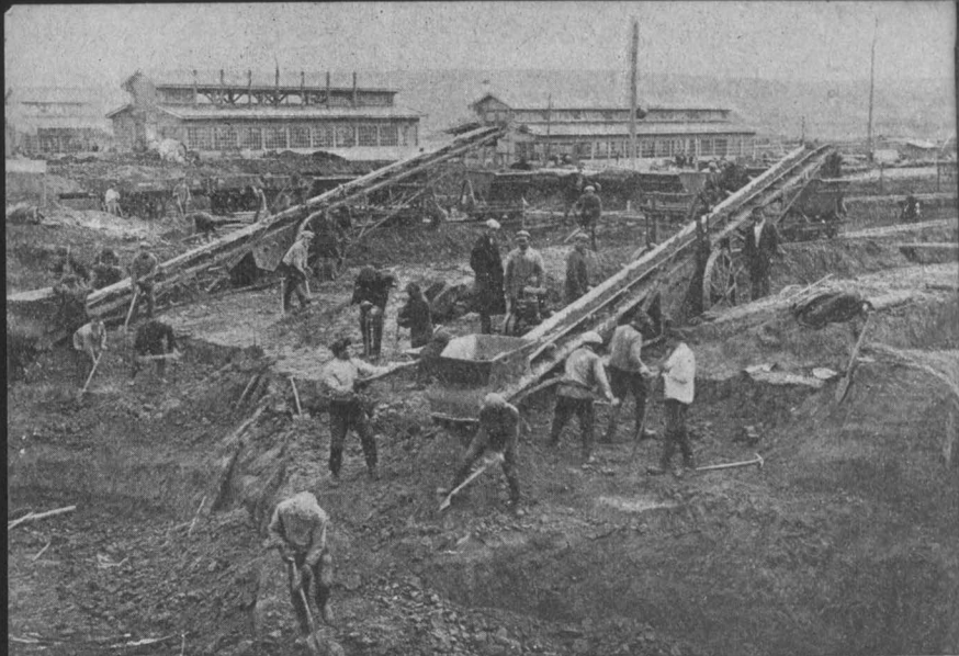
Первый день земляных работ на доменном цехе Кузнецкстроя (апрель 1930 г.).
