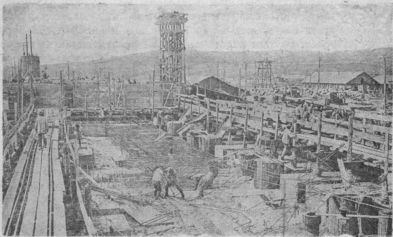
Котлован вырабатывается уступами, и глубина его равна росту двух человек. Отвесный борт начинается толстым слоем чернозема, а ниже идет сплошная плотная желтая глина.
