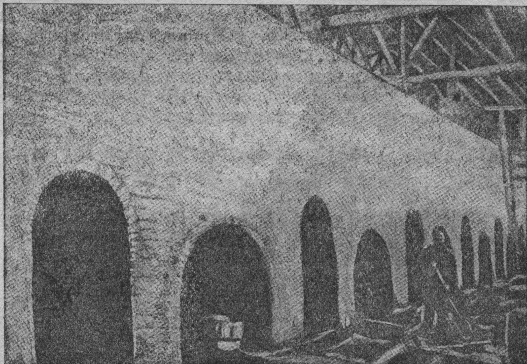
Печь для обжига в огнеупорном цеху.
