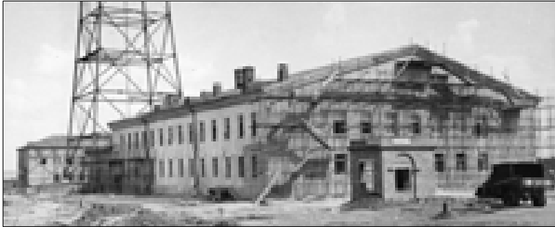
Строящееся здание телецентра
