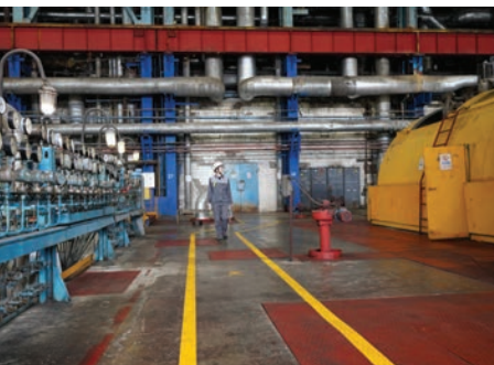
Турбинный цех Кемеровской ГРЭС (2023 год)
