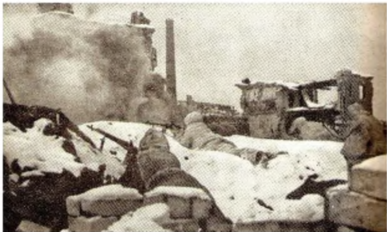
Штурмовая бригада на заводе “Баррикада”.
